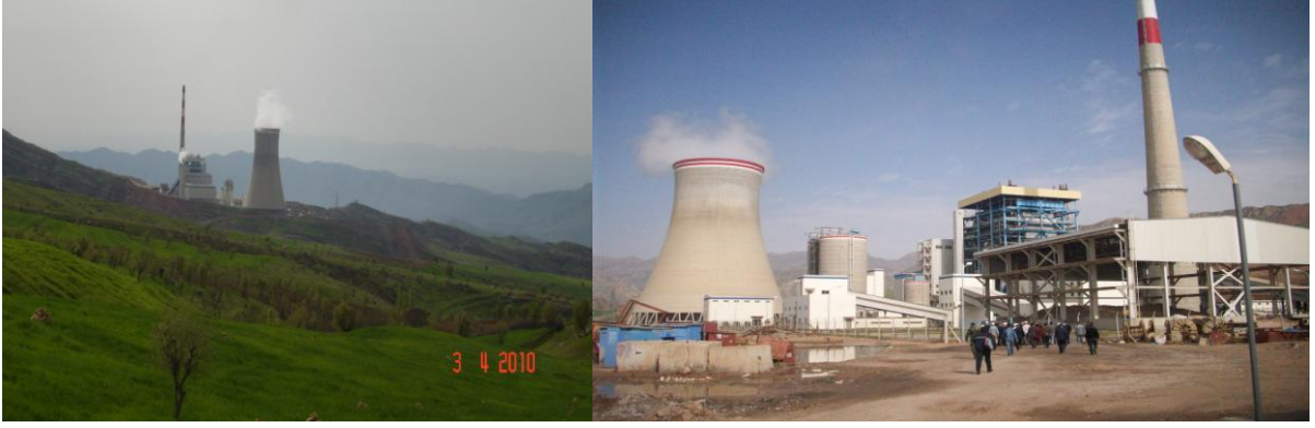
Resim 23. Silopi Termik Santrali
