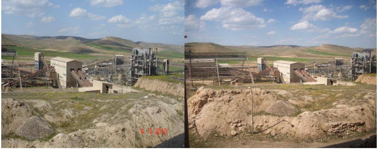
Resim 29. Atıl Durumdaki Mardin Mazıdağı Fosfat Tesisleri
