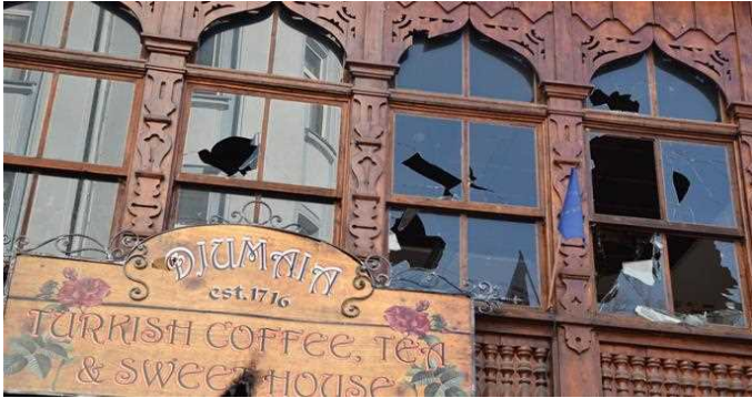
Bulgaristan Filibe şehrindeki Murad Hüdavendigar Camisi'ne göstericiler tarafından camiye atılan taş, sis ve ses bombaları sonucu oluşan hasar
